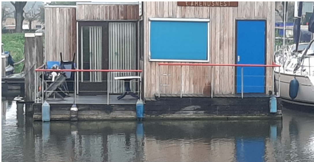
Op bijgaande foto's van het Arendsnest is te zien dat het ponton waar dat op staat aan de zuidkant wat meer uit het water steekt dan aan de noordkant.....
