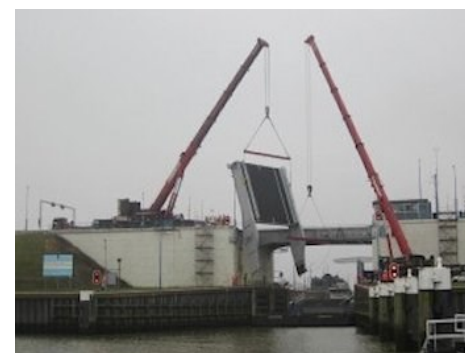
'Het inhangen van de brugdelen in januari..'
