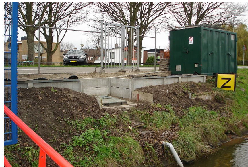
'Werkzaamheden voor de nieuwe toegangspoort'
